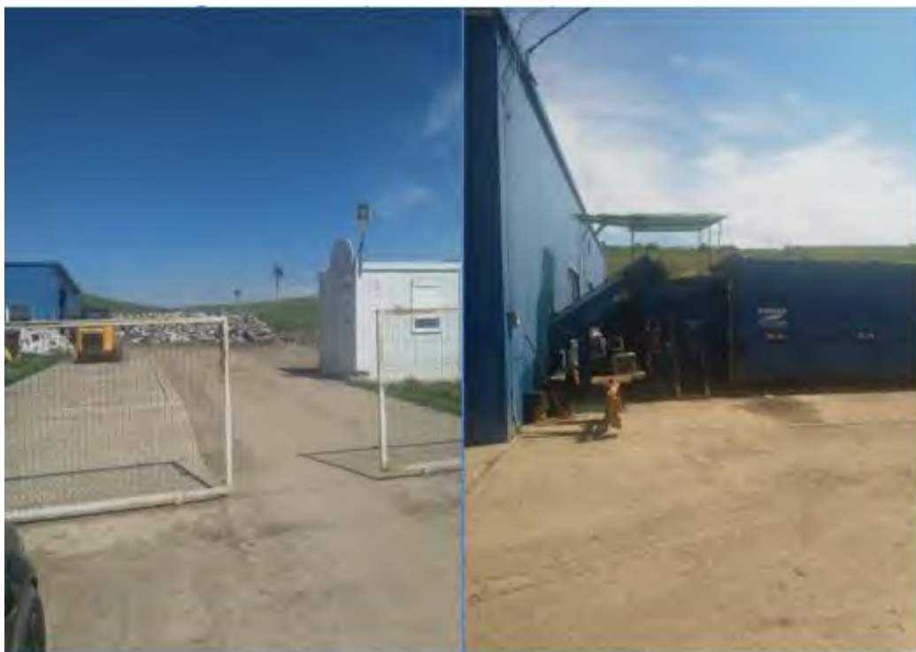
Figura 38: Stația de transfer și sortare Hârlău (sursa: BEI, Planul Județean de Gestionare a Deșeurilor în Județul Iași (2019-2025))
